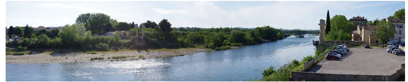
Figure 128: Vestiges du pont suspendu sur la Gard (5) à Remoulins
